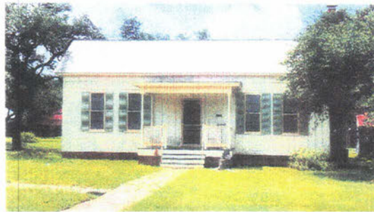
Dobie House (Old Kyle Rd)
